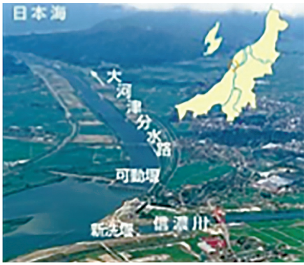
大河津分水路と可動堰 (出典: 北陸地方整備局ホームページ)
